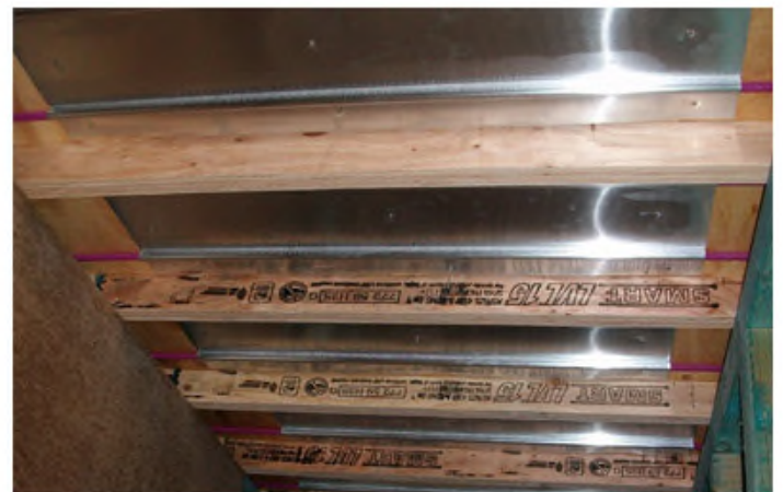
^^ Diffusion Plate (REHAU) Installation ^^
