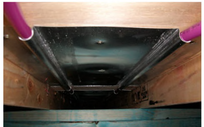
^^ Diffusion Plate (REHAU) Installation ^^
